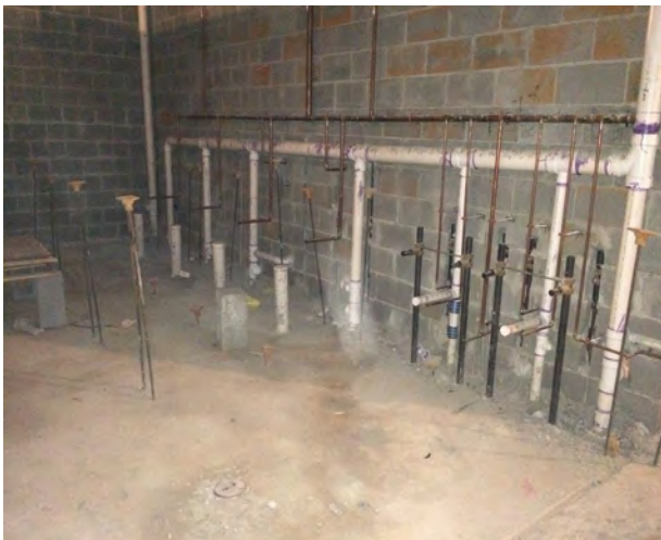
Area B Inwall Plumbing
